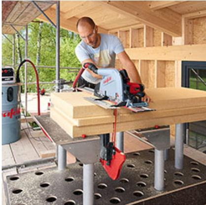
Egal ob Längs-, Quer- oder Schrägschnitt: Das steckbare System für druckfeste und flexible Dämmstoffe kann individuell an jede Schnittsituation angepasst werden. Auch auf dem Gerüst.
